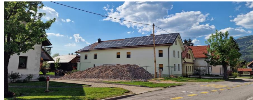
Problematičen primer umestitve fotonapetostnih naprav na stavbo znotraj območja naselbinske dediščine Žerovnica – Vas (EID 1-00898)
