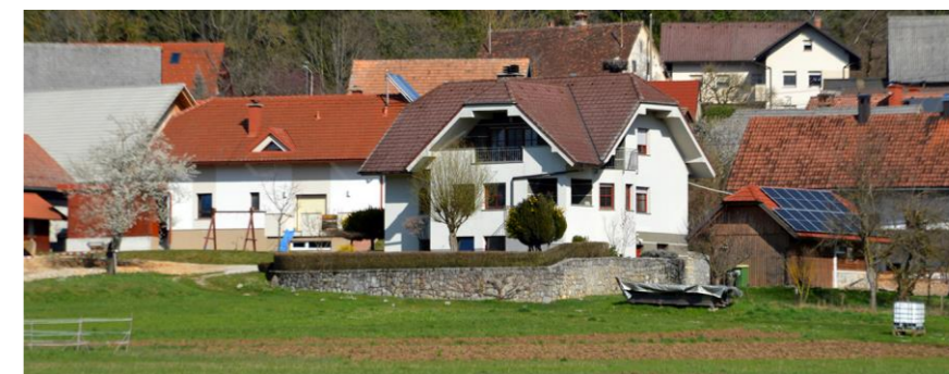
Spodbujanje sistematičnega urejanja robov naselij in stavb: ohranjen del sadovnjaka ob robu poselitve Rakeka (zgoraj) ter vidno izstopajoča in arhitekturno neprimerna stavba brez ozelenjenega roba pri Gorenjem Jezeru (spodaj)
