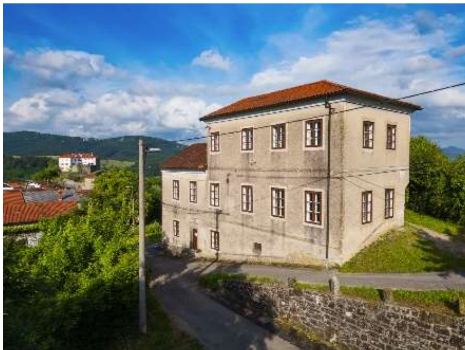
Slika 8: Stavba nekdanje premske osnovne šole. Vir: arhiv Občine Ilirska Bistrica
